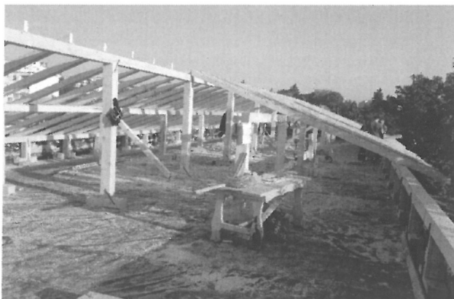
acoperișul corp A
